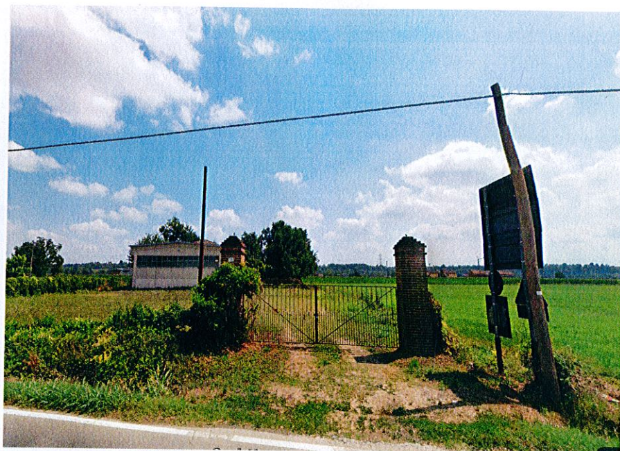
Figura 1: Accesso esistente all'area R6.11a, sulla SP3.
